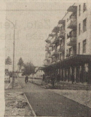
Asfaltiranje hodnikov se nadaljuje
