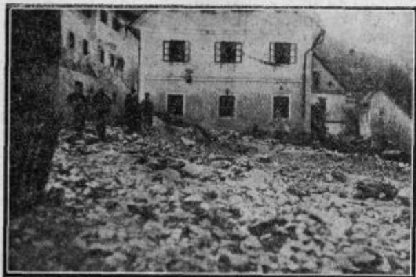
Spodnja Idrija. — Na zasutem mestu je stala strojarna Svetličič, ki jo je voda do temeljev izlizala. Fot. Bajt Fr., Idrija.
