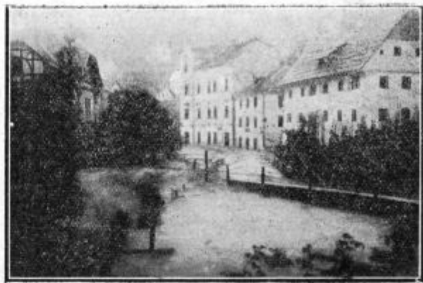
Idrija. Rimska ulica. Hiše so do prvega nadstropja pod vodo.
