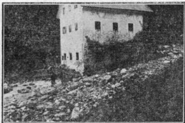
Hiša na Marofu pri Idriji, kjer je voda odnesla dve dekleti. Voda je segala do črne črte na hiši.
