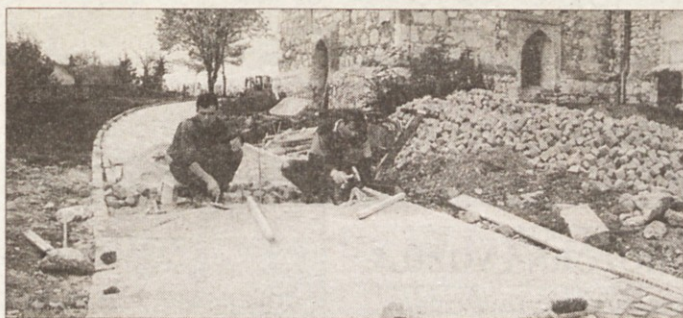
TLAKOVANJE NA KAPITLJU - Pred kratkim so začeli urejati pot ob kapiteljski cerkvi. Dosedanjo peščeno pot tlakujejo z granitnimi kockami, ob tem bodo uredili še del drenaže cerkvenih temeljev. Dela so usklajena z novomeškim Zavodom za varstvo naravne in kulturne dediščine. (Foto: A. B.)
