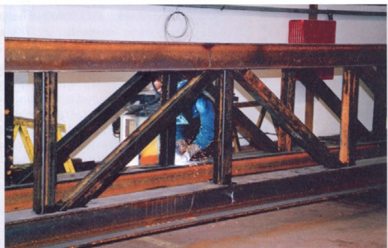
...varjenje veznega elementa nadstrešnice za sortiranje in čiščenje lokov...
