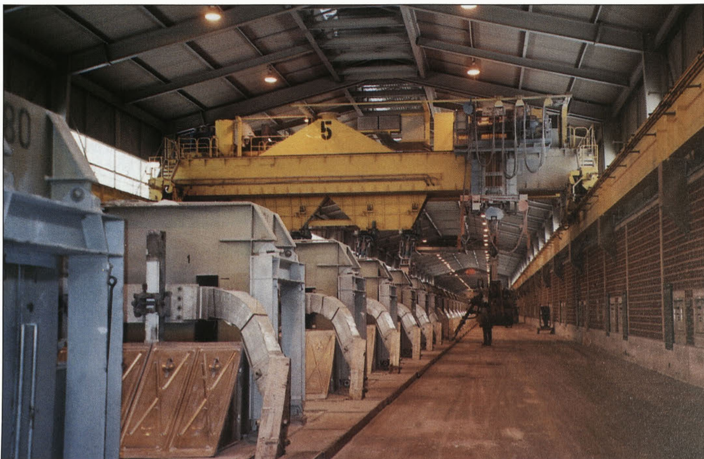
Elektrolizna hala C
