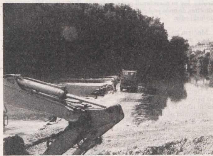
OBNOVA JEZU NA ŽAGI - Pred dnevi je novomeško Vodnogospodarsko podjetje začelo obnavljati novomeški jez "na žagi", ki je bil že precej načet in "skrbast". Jez bodo obnovili in zatesnili in tako se bo gladina Krke nad njim dvignila za okoli 30 cm. Dela bodo stala 25 milijonov tolarjev, denar je zagotovilo ministrstvo za okolje in prostor, dela pa naj bi bila končana do začetka septembra. Energetska izraba jez "na žagi" ni predvidena. (Foto: A. B.)
