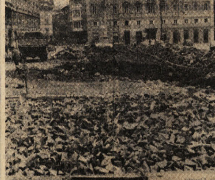
Cestičke pred občinsko palačo na Trgu Unità je že nekaj časa razkopano, ker urejajo novo kanalizacijo in druge podzemeljske napeljave
