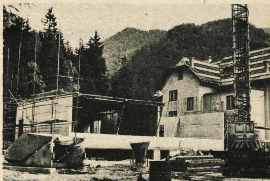
Iz sredstev sklada za gradnjo šol in vzgojnovarstvenih ustanov, kamor se natekajo tudi sredstva iz samoprispevka občanov iz kranjske občine, na Jezerškem gradijo prizidek pri osnovni šoli. V prizidku bodo večnamenski prostor s telovadnico, dve učilnici in prostor za družbene organizacije. V poslopju se danje šole pa bo tudi mlečna kuhinja. Doslej dela potekajo po programu. Tako naj bi bila šola dograjena do januarja prihodnje leto. — A. Ž. — Foto: F. Perdan
