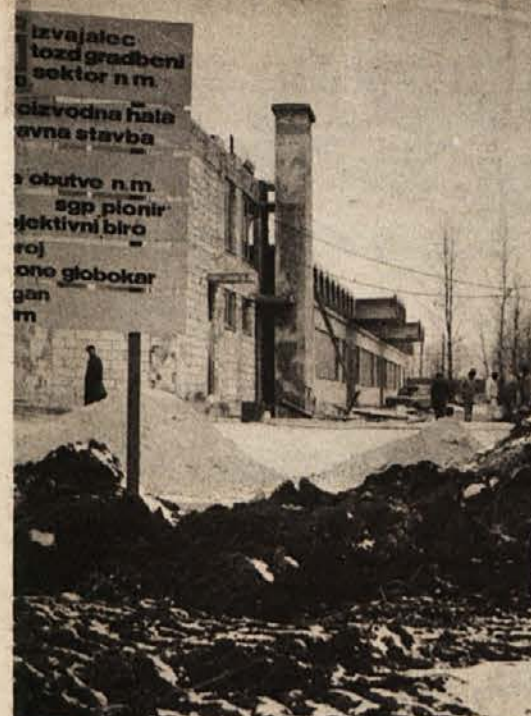
NOVI PROSTORI INDUSTRIJE OBUTVE – V Bršljanju dokončuje Pionir gradbena dela pri gradnji proizvodnih in upravnih prostorov Industrije obutve, ki se bo z mesta selila na boljše. Te dni začno nameščati opremo, preselitev pa je predvidena za marec. (Foto: R. Bačer)
