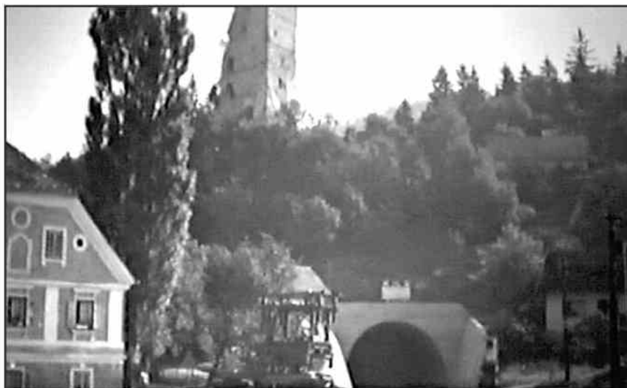
Gradnja predora pod gradom Šalek (arhiv Muzeja Velenje)
