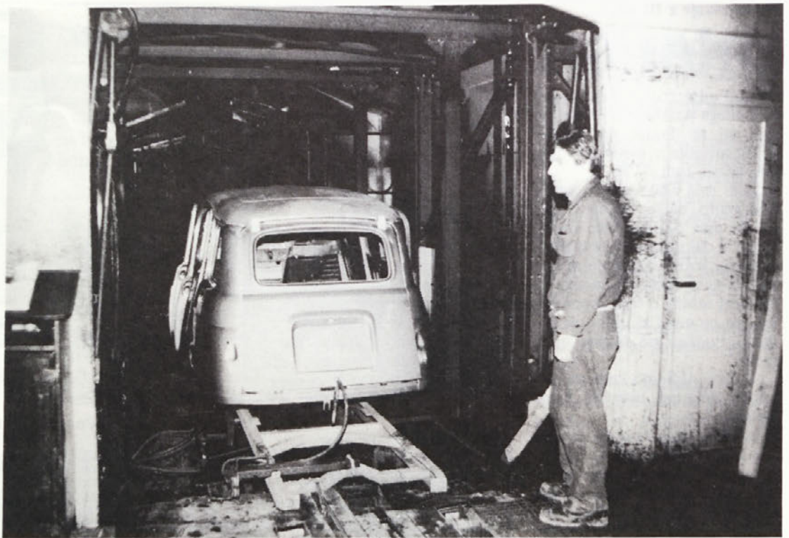
Ocejevanje elektrotretskega laka, nato izpiranje pred sušenjem
