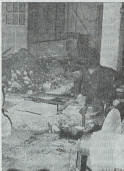
Polaganje električnega kabla za škrobilni stroj
