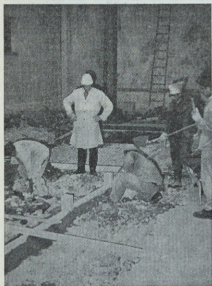
Betoniranje temeljev za škrobilni stroj
