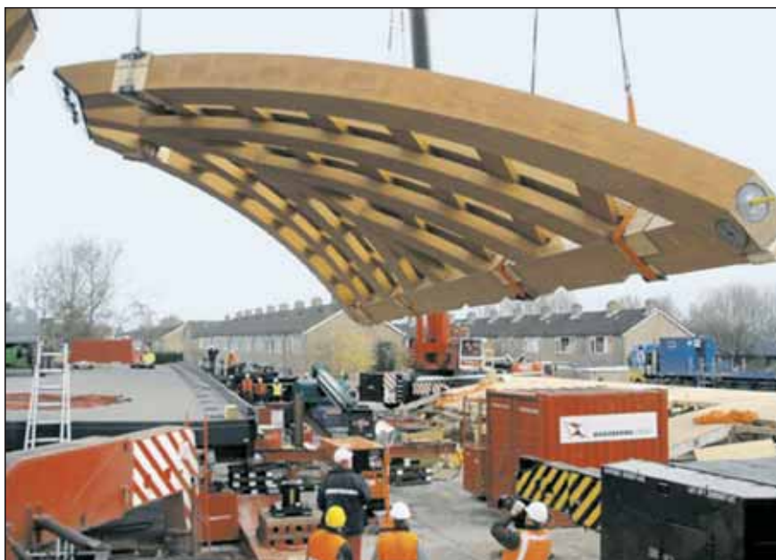
Eden od dveh 32 metrov dolgih in 16 metrov visokih lesenih lokov novega mostu
