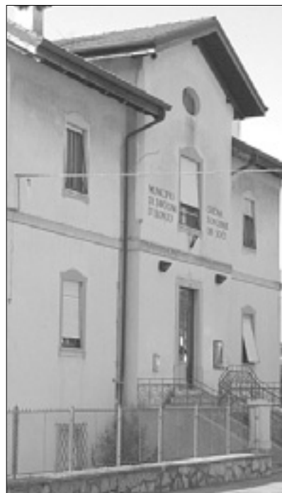
Občinska stavba v Sovodnjah BUMBACA
