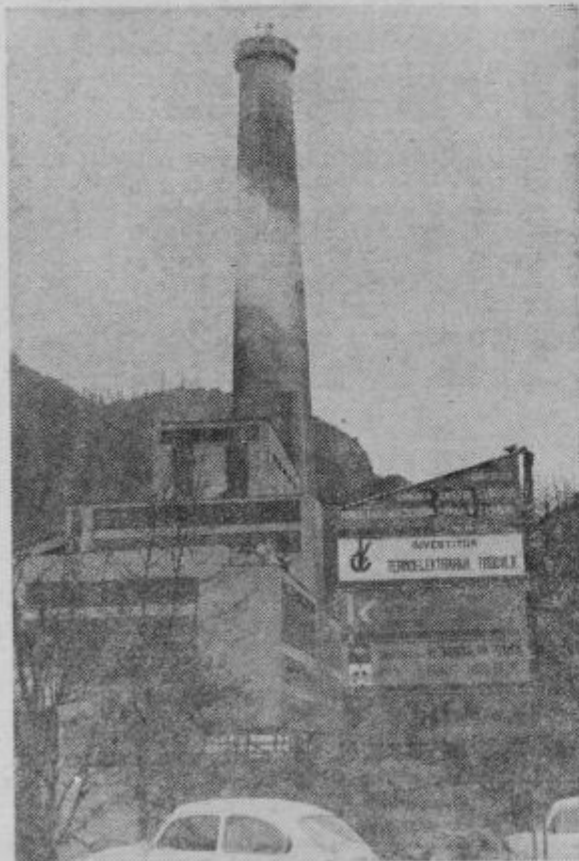
Vse više in više . . . Kolektiv celjske enote Gradisa sodeluje tudi pri gradnji najvišjega dimnika pri nas, pri postavitvi 360 m visokega dimnika termoelektrarne v Trbovljah
