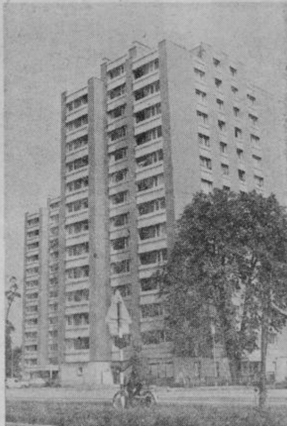
Vse več novih stanovanj. To je potreba in zahteva današnjega časa. Gradis ji je sledil. Samo na Otoku III v Celju je okoli 600 lepih stanovanj. Stolpnica ob Copovi ulici je zadnje delo iz tega poglavja in na tem območju.
