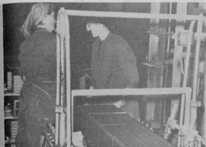
Izdelava zidnih opečnih elementov
