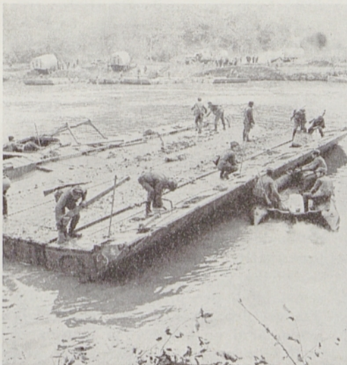
Gradnja pontonskega mostu
