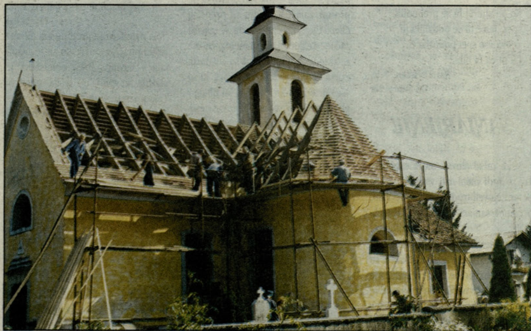
Pri obnovi strehe
