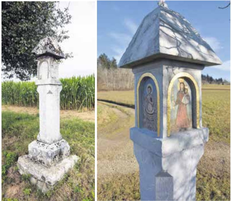
Znamenje pred obnovo
