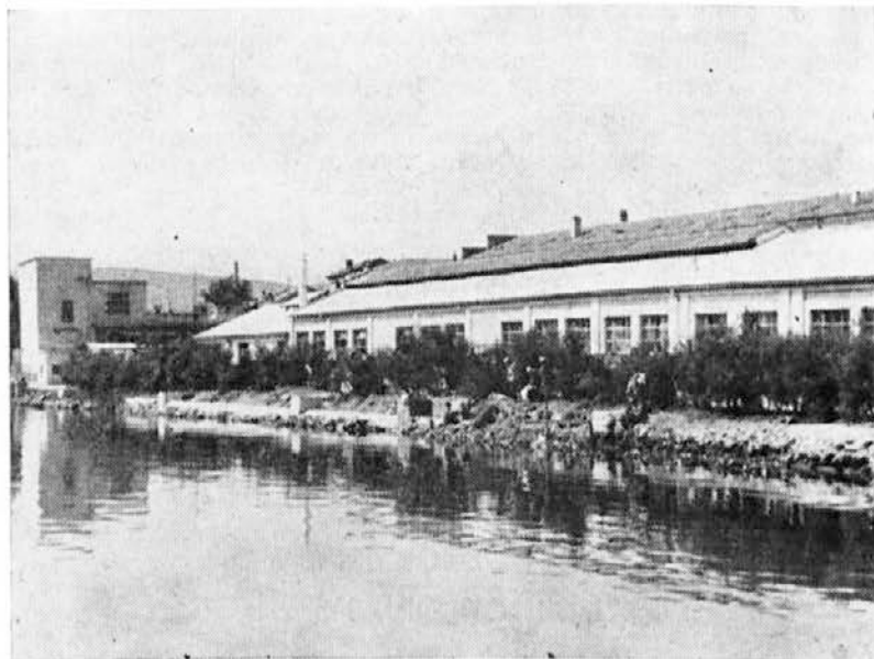
Pogled na obalo z vgrajenim kanalom
