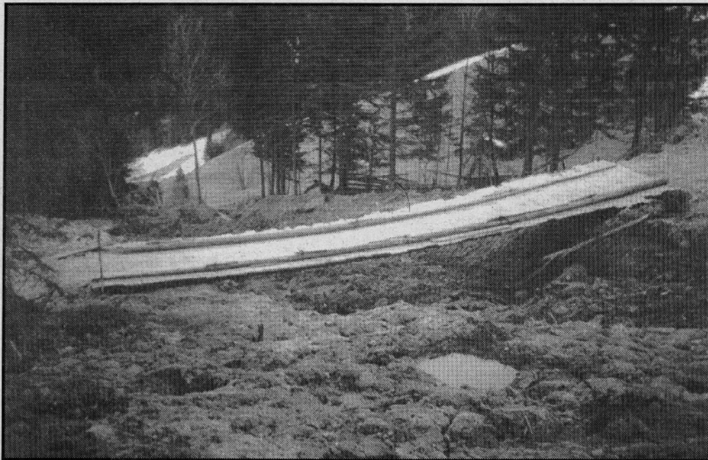
Improviziran most preko plazu
