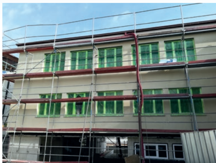
Nastajanje fasade na prizidku k OŠ Ig
