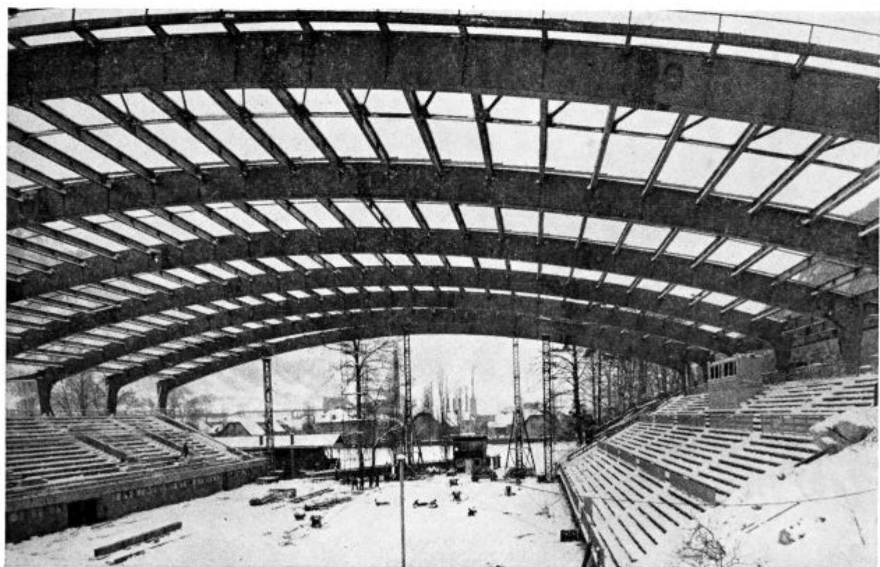
Jeklena konstrukcija za hokejsko halo na Jesenicah Kvaliteta jekla: Nivoal 47
