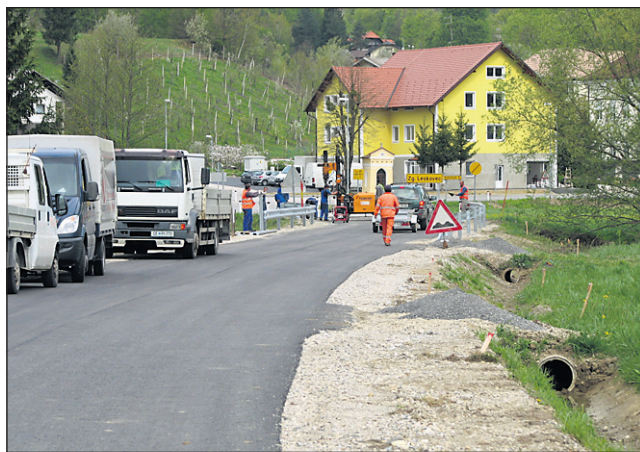
Letos bosta modernizirana še dodatna dva kilometra državne ceste iz centra Leskovca proti mejnemu prehodu Zg. Leskovec, za kar bo iz državne blagajne porabljenih približno 688.000 evrov. Foto: SM
