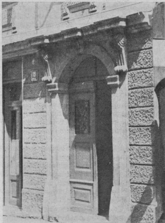
Portal hiše št. 15 na Gornjem trgu
