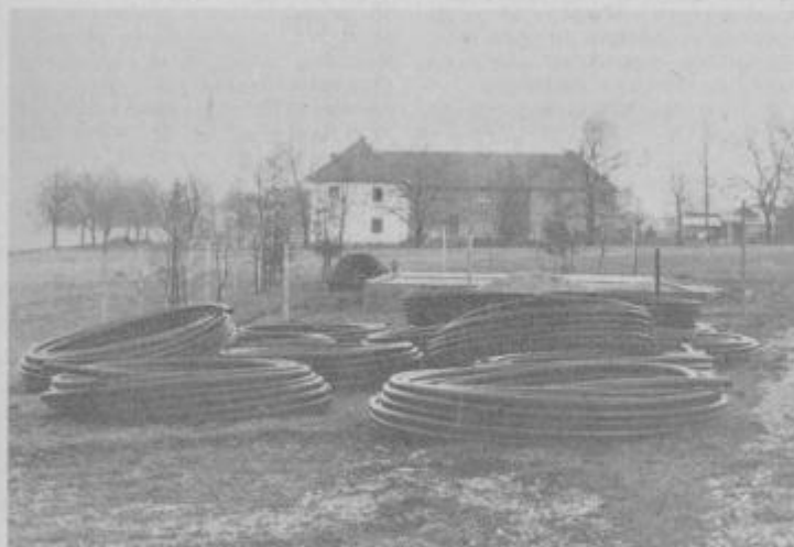
Pripravljene vodovodne cevi za vodovod na področju KS Ivanjkovci. V ozadju je poslopje žerovinskega združnega doma, kjer je tudi dvorana. Foto: J. Rakuša
