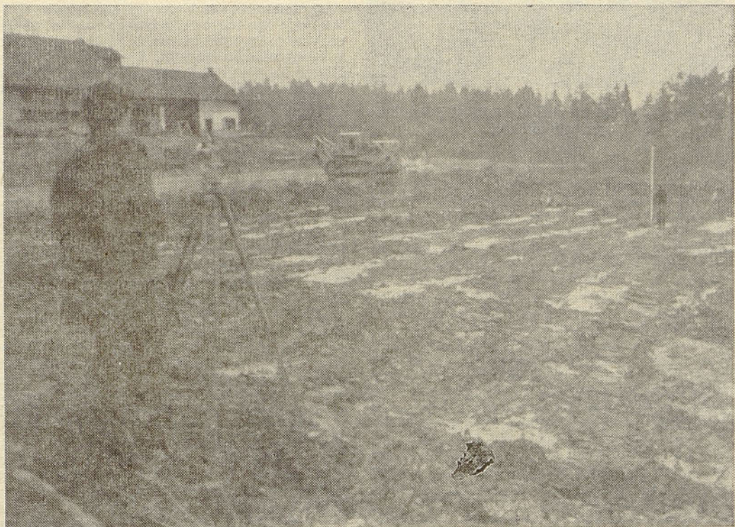
Na Žovneku so že krepko začeli z delom za vzrejni center za 600 plemenskih telic. Center bo predvidoma končan že maja.
