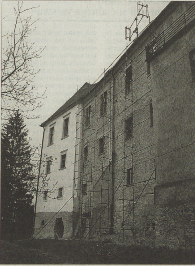
Hercog je zelo zgodaj spoznal, da je s spomeniškim varstvom bolje sodelovati, kot se pripraviti. Na vrsti je najtežji del fasade, ki je bil ometan z betonskim ometom; sedaj je pred njimi še ena naloga: odstraniti morajo balkon na desni strani, ker da ni »originalen«.
