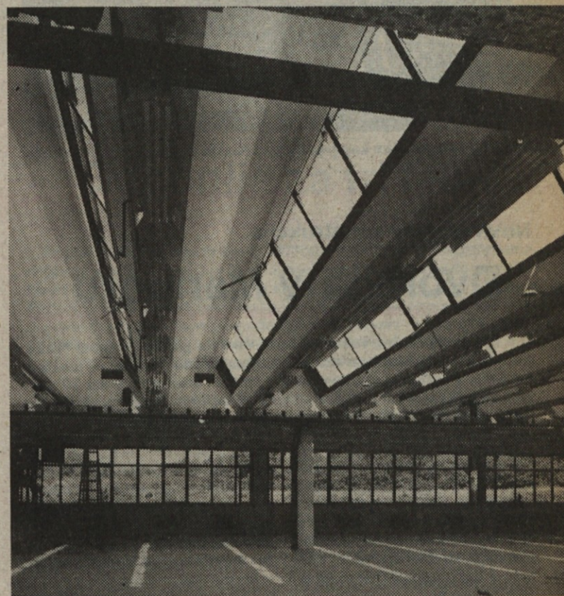
ŠED streha na hali za Iskra-Otoče, nova krovna konstrukcija Projektivnega biroja iz Maribora spušča v prostor veliko svetlobe
