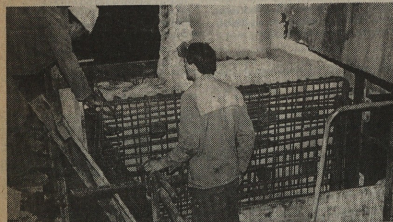
Za nove nosilce portalnega žerjava je bilo potrebno okrepiti pete stebrov. Na sliki pripravljajo jekleno armaturo, zatem bodo pete obbetonirali
