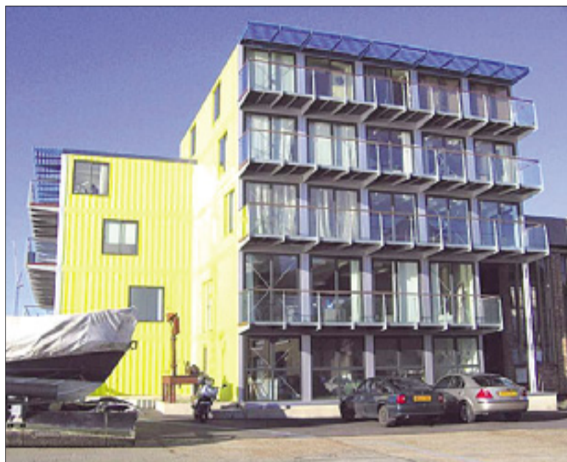
Večnadstropno kontejnersko stanovanje; estetsko se ne razlikuje od klasično grajenega
