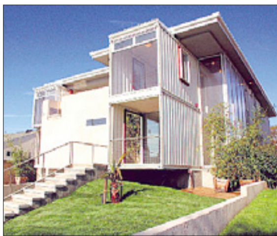
Dvonedstropna hiša zgrajena z mešanim sistemom; kombinacija kontejnerjev ter klasičnih materialov
