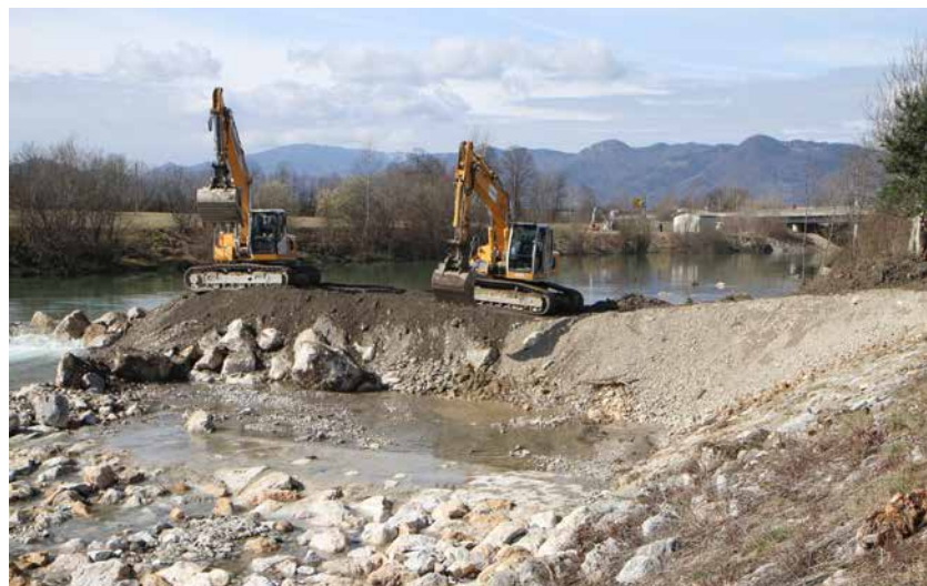
Dela pri sanaciji drče na Savinji v Ločici pri Polzeli
