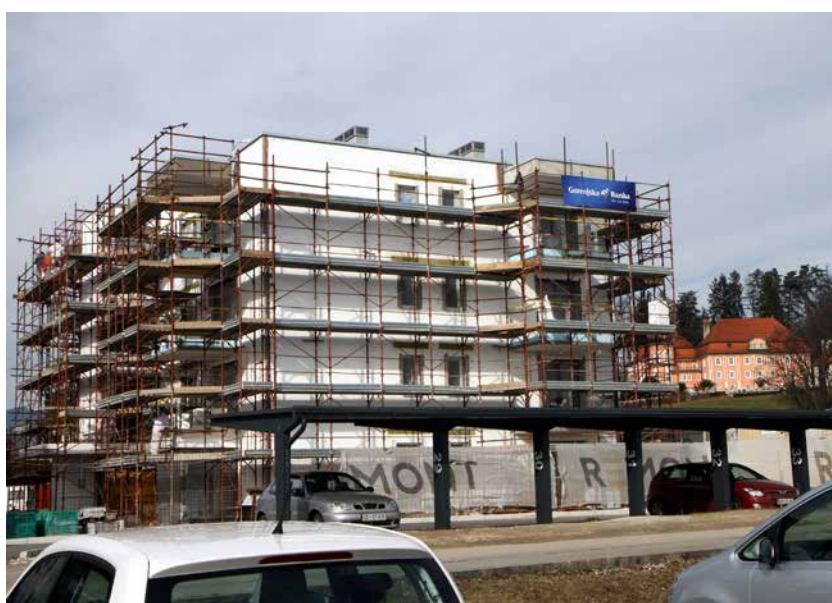
Gradnja 19 oskrbovanih stanovanj je v polnem teku.
