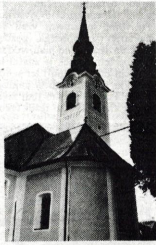
Obnovo cerkve so končali minuli mesec.
