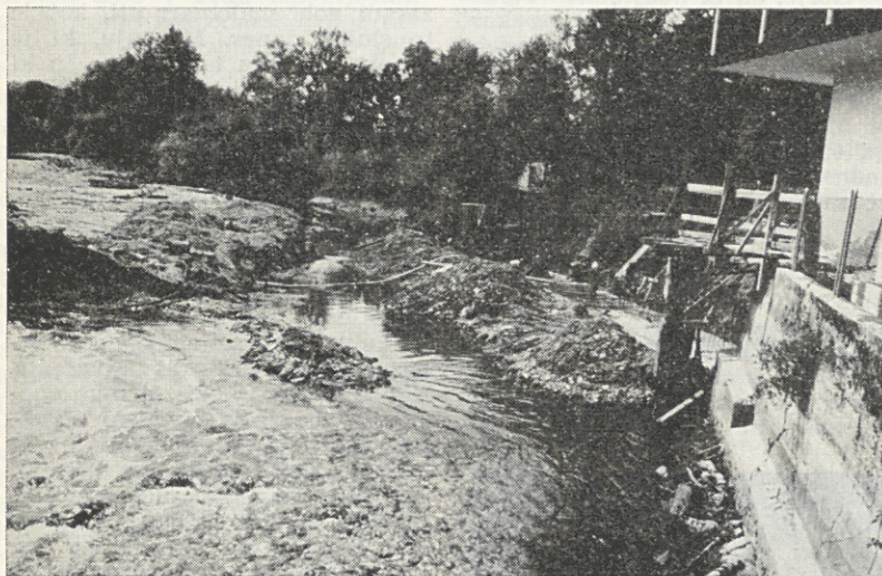
Med sanacijo obrežja pri tapetah
