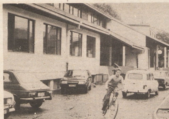
STAVBA V STRUGAH GOTOVA — Prejšnji petek so v Strugah zaključili gradnjo večnamenske stavbe. V stavbi (na fotografiji) je na 1.200 kv. metrih prostor za osemletko, dve stanovanji, pošto, večnamensko dvorano ter krajevn-i urad in pisarno krajevne skupnosti. Za sodelovanje v gradnji so na zadnji seji gradbenega odbora podelili priznanja IS SO Kočevje, Komunalni, SGP Zidar, Gozdemno gospodarstvu in stanovanjski skupnosti iz Kočevja ter IBT-Projektivnemu biroju, posestvu Snežnik Kočevska reka in KS Struge. (Foto: Primc)
