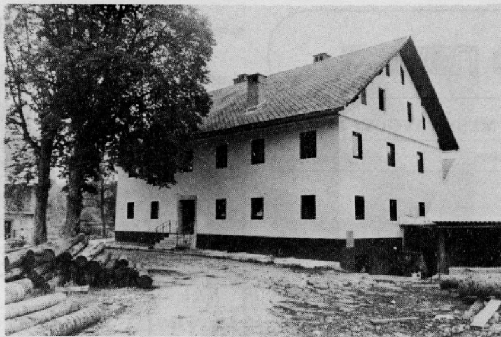
Stanovanjska hiša na bivšem obratu Lancovo po končani adaptaciji, v kateri je sedaj sedem stanovanj s 322 m 2 skupne površine.
