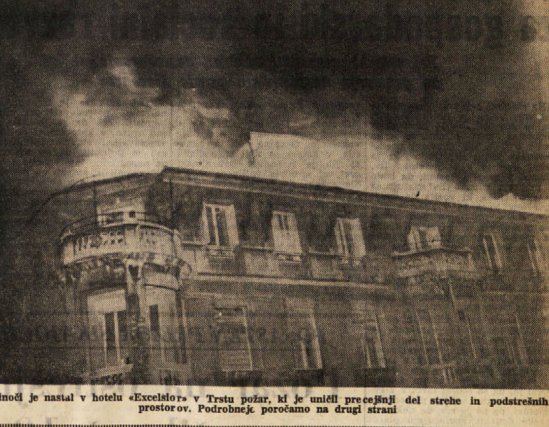
Smolci je nastal v hotelu »Excelsior« v Trstu požar, ki je uničil precejšnji del strehe in podstrešnih prostorov. Podrobneje poročamo na drugi strani
