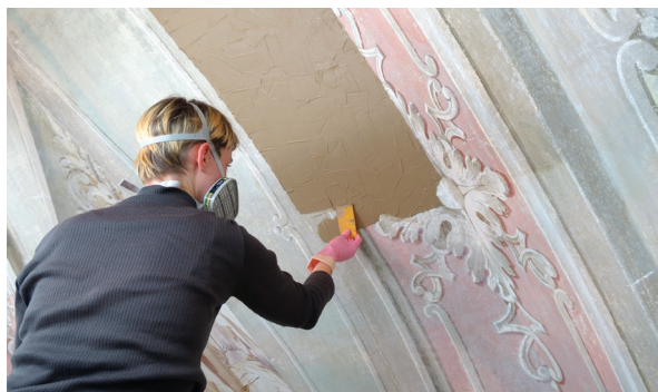
Kemijsko odstranjevanje nečistoč se je izvajalo z nanašanjem oblog iz triamonijevega citrata in EDTA v ustreznem razmerju, nosilec je bil sepiolit. (foto: Anita Kavčič Klančar)
