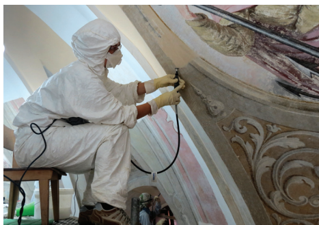
Odstranjevanje zatrdelih beležev z minirotacijskimi brusilniki (Dremel).
