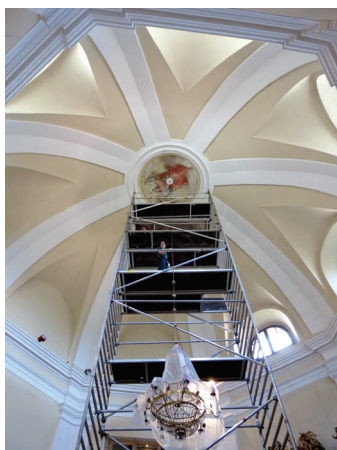
Postavitev začasnega premičnega odra ob sondiranju poslikav. (foto: Anita Kavčič Klančar)
