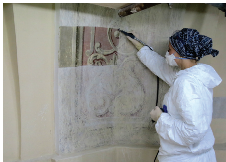
Odstranjevanje zatrdelih beležev z minirotacijskimi brusilniki (Dremel).
