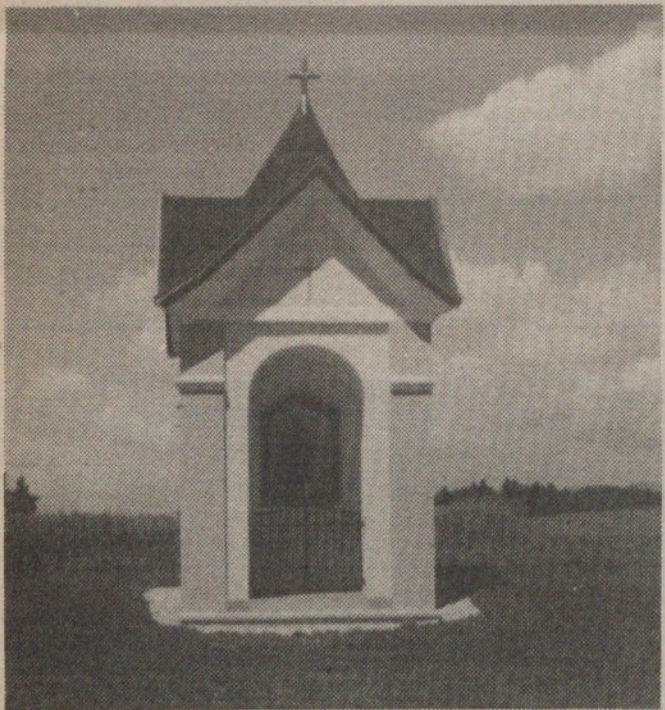
Uštinčeva kapelica je bila pred nedavnim obnovljena in je lahko vzgled, kako se z mnogo prizadevnosti obnovijo taki in podobni kulturni spomeniki.
