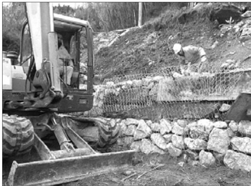
Utrjevanje zemljišč na pobočju nad Ul. Pianezzi - Rio Storto
