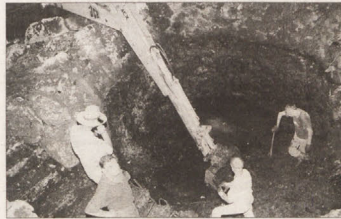
URŠENSKI BEČ - Po več kot 50 letih so Uršenski beč, starodavni obzidan kraški izvir pri Uršnih selih, očistili in uredili. Vanj se spet steka čista voda iz neokrnjene narave. (Foto: A. B.)
