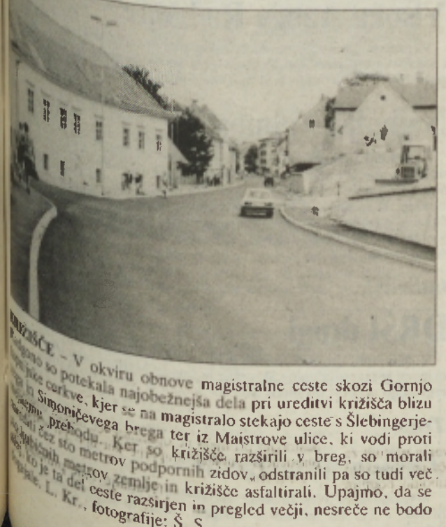
... V okviru obnove magistralne ceste skozi Gornjo Pomurje so potekala najobsežnejša dela pri ureditvi križišča blizu cerkve, kjer se na magistralo stekajo ceste s Šlebingerjevega brega ter iz Majstrave ulice, ki vodi proti Prehodu. Ker so križišče razširili v breg, so morali zgraditi deset metrov podpornih zidov, odstranili pa so tudi več starih zidov. V ta del ceste razširjen in pregled večji, nesreče ne bodo. Fotografije: Š. S.
