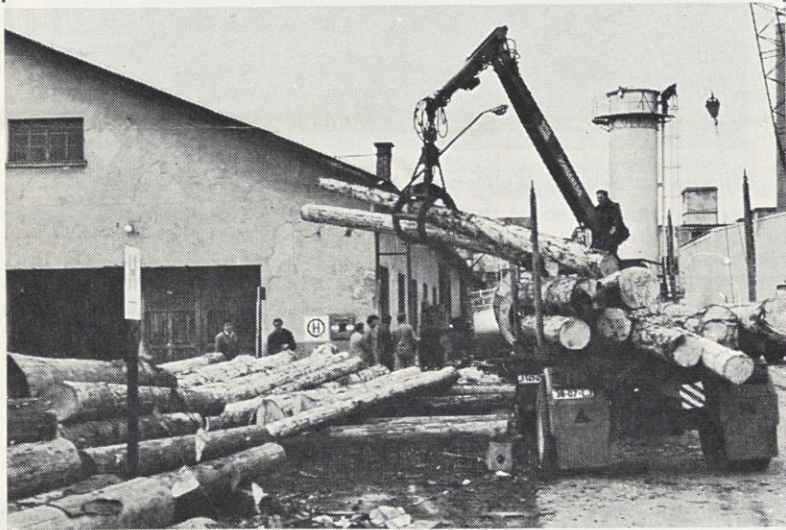
Tudi žaga in ostali oddelki lesne predelave se bodo verjetno morale umakniti. Strojni park izpodriva lesno skladišče (Foto: C. Zupančič)
