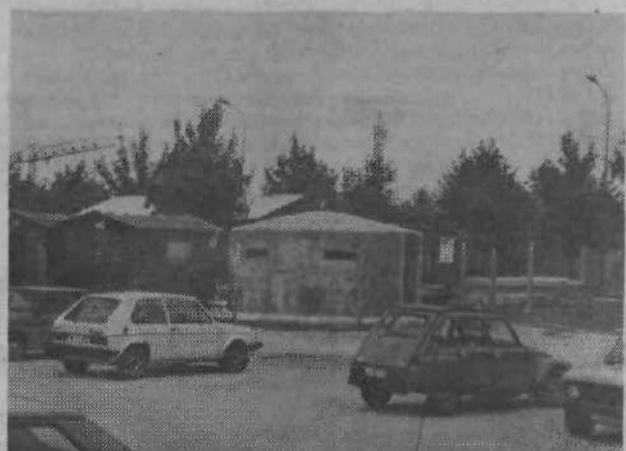
GIPOSS inženiring kot investitor in celjski Ingrad kot izvajalec sta začela pripravljati dela za zidavo garažnega objekta s streho na začetku Trebinske ulice v soseski, ki jo še najbolj poznamo po stari štiri BS-3, zdaj pa sodi v ureditveno območje BS 2/5 – Nove Stožice. Kljub vsem ustreznim dovoljenjem, s katerimi je soglašala tudi krajevna skupnost Ivan Kavčič Nande, pa so okoliški stanovalci zagnali vik in krik, ker takšni gradnji nasprotujejo. Kakšen utegne biti razplet – ali nadaljevanje del ali kaka druga rešitev, primernejša zahtevam krajanov – do zaključka redakcije ni bilo znano, zato bomo o tem poročali tudi v naslednji številki.
