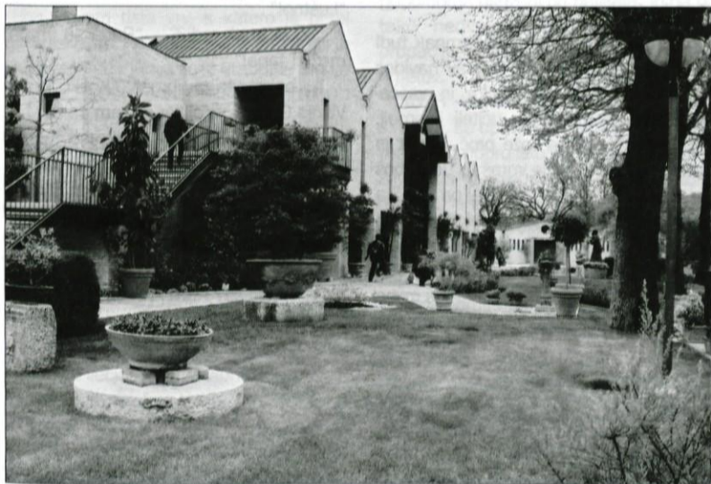
Zgradbe in okolica - skladnost v okolju se zliva z novim načinom življenja.
