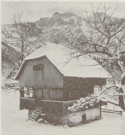
Makekova kašča, zanimiv primerek jezerske arhitekture
