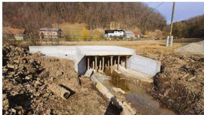
Domačini so se lotili gradnje vodnega prepusta čez potok Peklača v vasi Dolena in delo uspešno končali. Foto: Darko Jerenec
