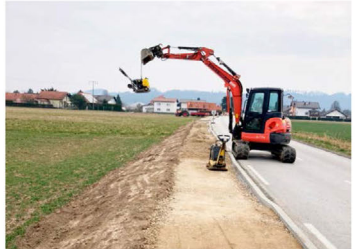
Ob glavni cesti Videm-Pobrežje je v izgradnji pločnik v dolžini 485 m.
