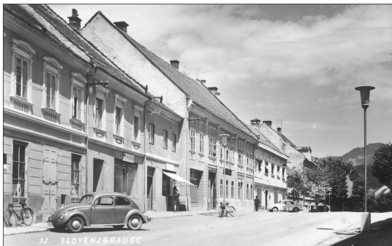
Slovenj Gradec, 1964. Štelcerjeva hiša, na fotografiji prva z leve. V pritličju so izložbena okna in vhodna vrata sedlarske delavnice. *
