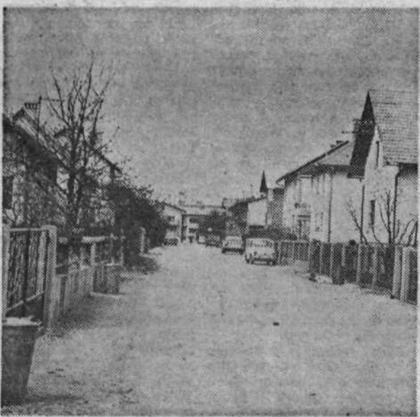
Za ureditev kanalizacije na Popovičevi ulici v Stožicah je iz prispevka za uporabo mestnega zemljišča predvidenih 280.000 din.
