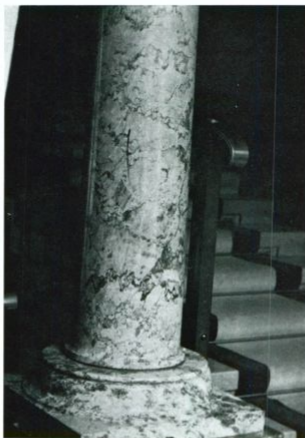
Sl. 2. Steber iz hotaveljskega marmorja na stopnišču iz 1. v 2. nadstropje v hiši trgovske zbornice v Ljubljani
