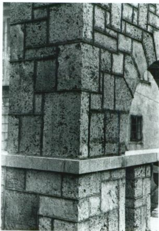
Sl. 3. Lehnjak z Jezerskega, v Kranju na Pungartu Fig. 3. Calc-tufa from Jezersko: Pungart in Kranj
