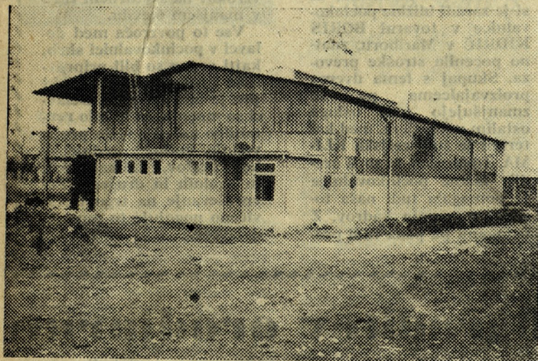
Stavba nove topilnice
